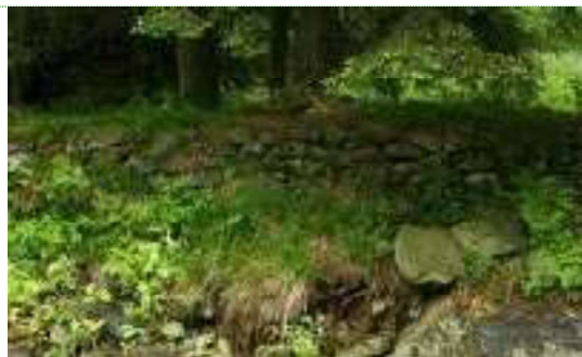
Fotografia 73. Murek kamienny bez zaprawy w Nadleśnictwie Łądek Zdrój, fot. M. Goździk.
