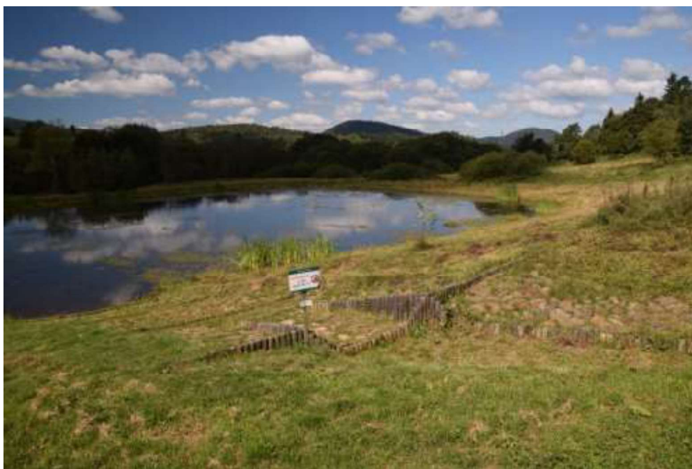
Fotografia 123. Końcowy ze zbiorników kaskadowych w Nadleśnictwie Baligród zasilanych z cieków a dodatkowo także wodą doprowadzoną z rowu przydrożnego – na pierwszym planie widoczne miejsce zasilania zbiornika wodą z rowu, fot. M. Mikulska.
