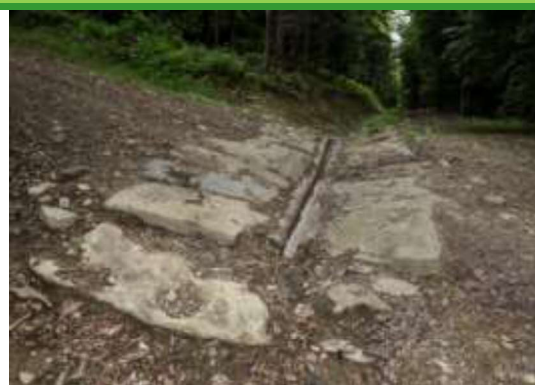
Fotografia 107. Wodospust odprowadzający wodę z drogi do lasu Nadleśnictwo Łosie (archiwum CKPŚ).
