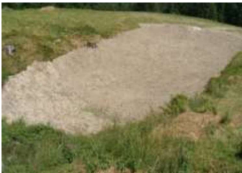
Fotografia 114. i Fotografia 115. Miejsca na mikrozbiorniki zasilane spływem powierzchniowym przygotowane w Nadleśnictwie Piwniczna (archiwum CKPŚ).
