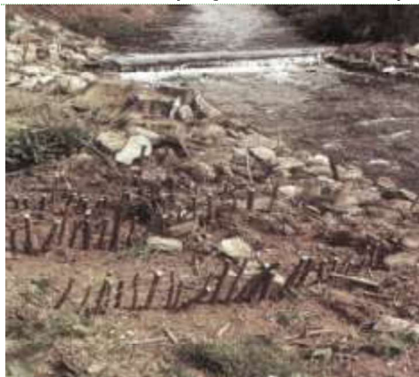
Fotografia 70. Płotek ze zręzów wierzbowych tuż po wykonaniu [Begemann i Schiechl 1999].
