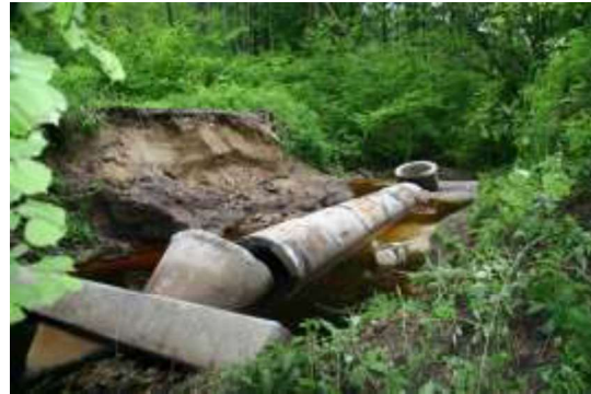
Fotografia 148. Straty powodziowe w 1997 r. – rozmyty przepust o zbyt małym świetle (archiwum CKPŚ).
