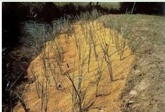
Fotografia 72. Umocnienie z siatki jutowej z sitowiem i sadzonkami pędowymi [Begemann i Schiechl 1999].
