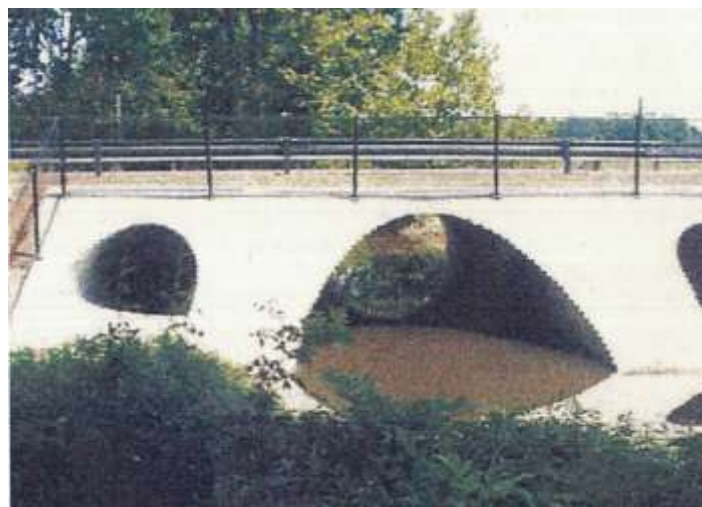
Fotografia 149. Przykłady wielootworowych przepustów z rezerwową przepustowością na wody powodziowe [Kosicki 2011].
