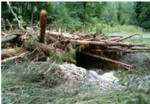
Fotografia 150. Rumosz niesiony wodą w czasie katastrofalnego wezbrania osadzony na moście (archiwum CKPŚ)
