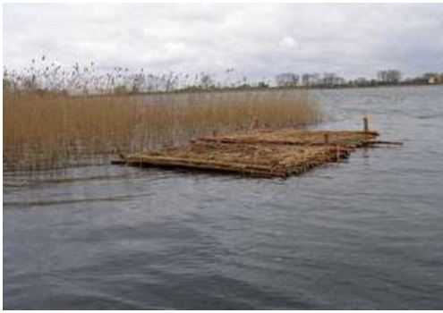
Fotografia 128. Pływająca wyspa - efekt jeszcze bez roślinności [http://old.zpkww.pl].
