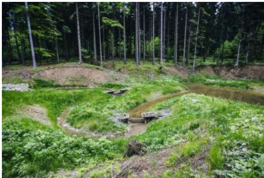
Fotografia 137. Zatoka zastoiskowa/mikrozbiornik i zastawki na dopływie – Nadleśnictwo Międzyzlesie (archiwum CKPŚ).
