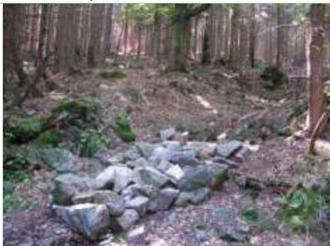
Fotografia 105. Narzut z gładów na szlaku zrywkowym (archiwum CKPŚ).
