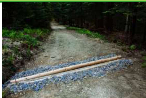
Fotografia 106. Wodospust z okrąglaków w Nadleśnictwie Gorlice, 2015 (archiwum CKPŚ).
