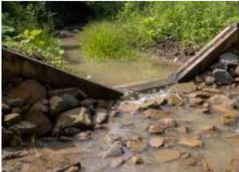
Fotografia 133. Próg powyżej brodu ukierunkowujący wodę na bród (archiwum CKPŚ).
