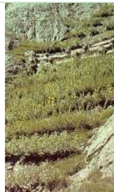
Rysunek 64. i Fotografia 65 Krzewiaste umocnienia tarasowe na skarpie/osuwisku [Begemann i Schiechl 1999].
